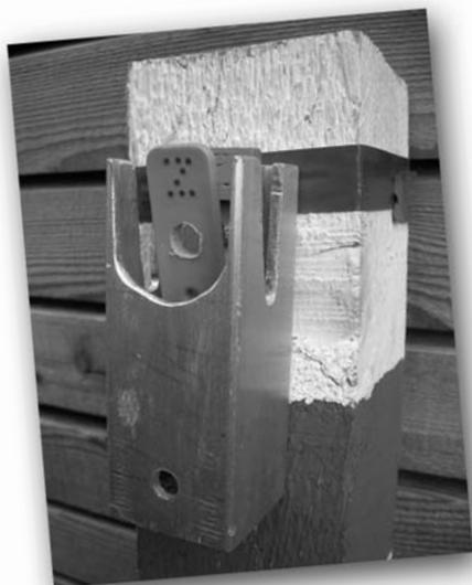
*Support fixe et vissé réalisé dans les montagnes neuchâteloises.*
