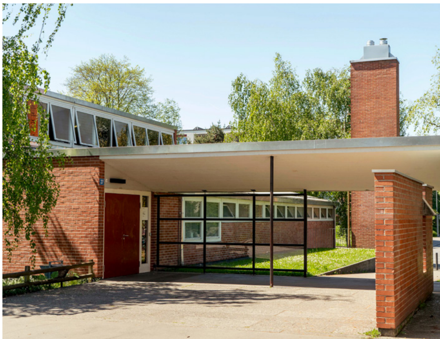
Die Pavillonschule Chriesiweg in Zürich Altstetten wurde seit ihrer Entstehung 1957 sanft renoviert.
