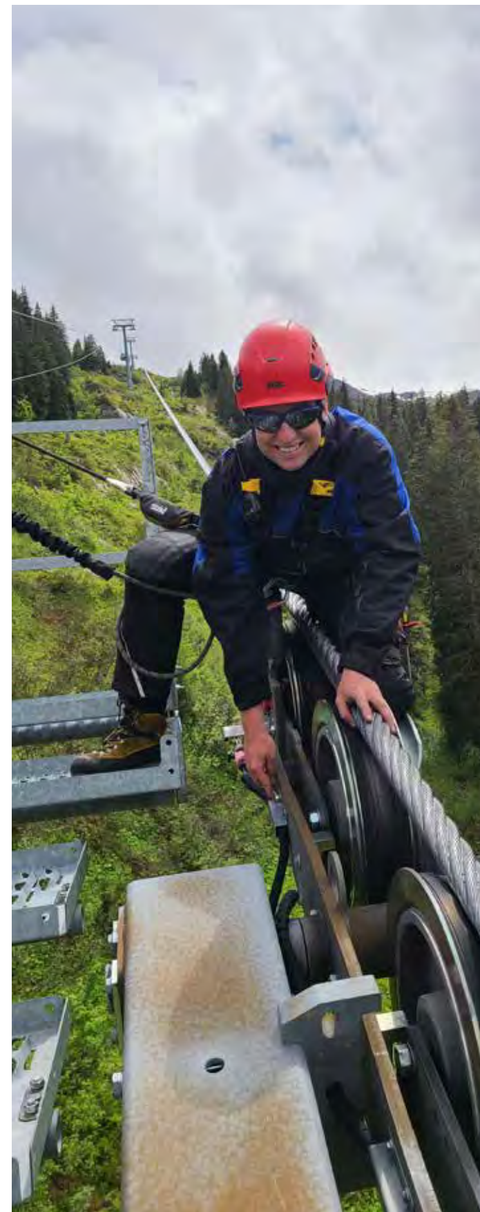
Alec Lang kontrolliert auf einer Stütze die Wippen und Rollen. (Bild: zVg)
