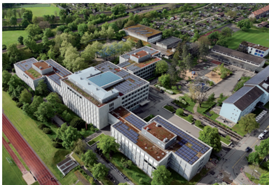
Foto: Gymnasium Bäumlhof Basel
