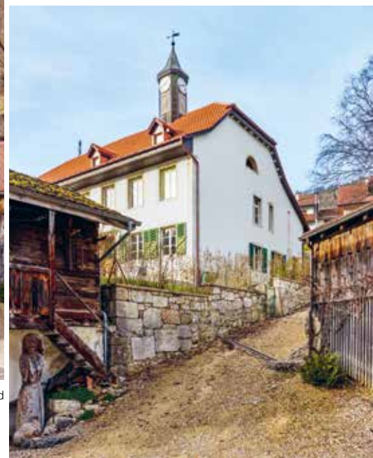
L'école repose sur un terrassement en pierre de taille. Photos : Dominique Plüss
