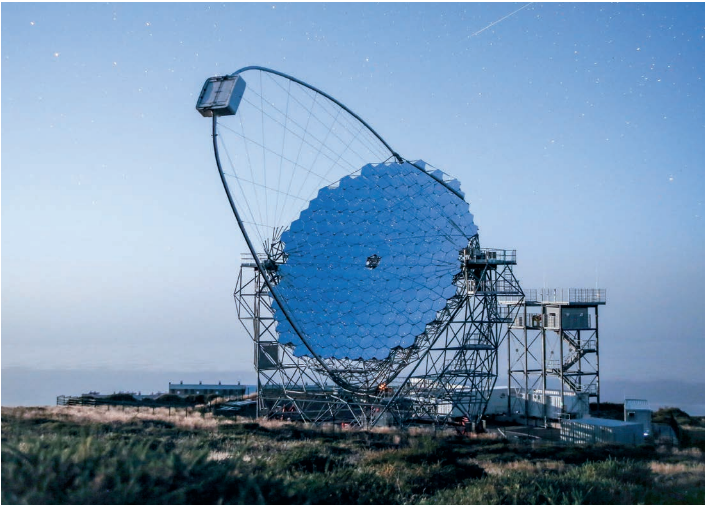
Der Prototyp eines grossen Teleskops von CTAO, genannt LST-1, auf der Kanaren-Insel Palma. Illustration: Tomohiro Inada
