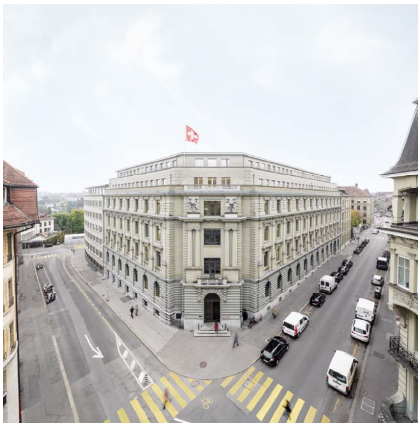
Abb. 14: Haus der Kantone, Speichergasse 6, Bern
