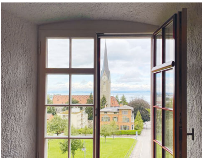
Die Fenstersanierung im Hochschulgebäude Marienberg ist abgeschlossen.
