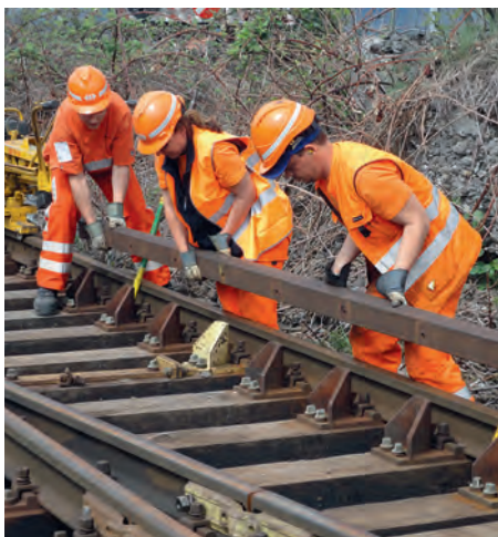
Bewerber des Lehrstellenexpress St. Gallen helfen, eine Weiche zu montieren.
