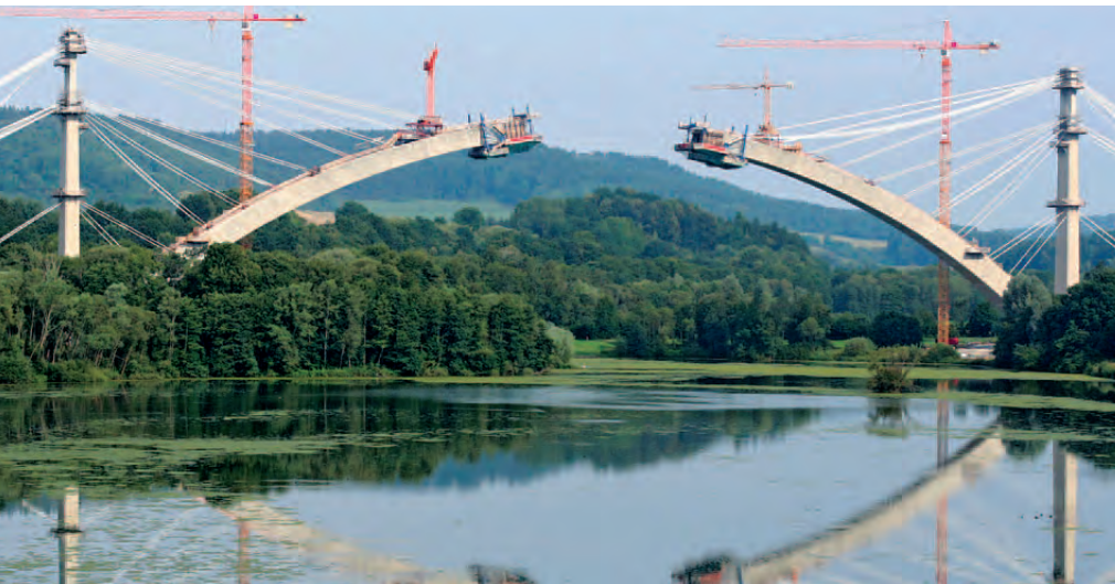
Die Brücke, die beide Ausbildungssysteme verbindet, wird neu gebaut.
