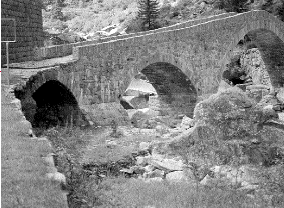
Häderlisbrücke als Teil des Gotthardsaumweges in der Schöllenschlucht (zwischen Göschenen und Andermatt). Die Brücke wurde 1649/1650 aus Stein gebaut. Beim Hochwasser von 1987 wurde sie zerstört und anschliessend wieder rekonstruiert.
