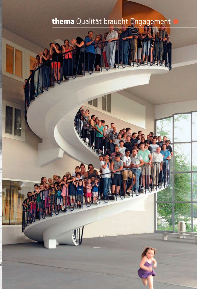
Der Belastungstest: Vor der Bauabnahme 1953 «durften» die Lernenden der damaligen Brown, Boveri & Cie. die noch geländerlose Wendeltreppe testen. Als erste Aktion des Kunstlehrstuhls wurde der Test 2012 von Künstler Christian Ratti wiederholt. Bilder: Historisches Archiv ABB Schweiz/Ayse Yavas, Kunstlehrstuhl BBB
