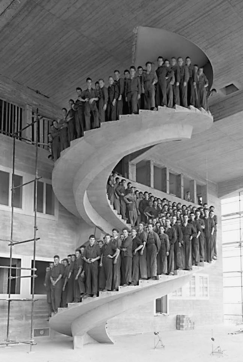
Der Belastungstest: Vor der Bauabnahme 1953 «durften» die Lernenden der damaligen Brown, Boveri & Cie. die noch geländerlose Wendeltreppe testen. Als erste Aktion des Kunstlehrstuhls wurde der Test 2012 von Künstler Christian Ratti wiederholt. Bilder: Historisches Archiv ABB Schweiz/Ayse Yavas, Kunstlehrstuhl BBB
