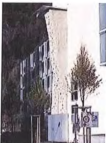
Mur d'escalade recouvert dans l'espace public
