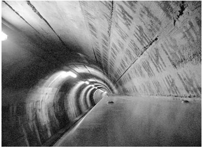
Eingangsstollen zur Zivilschutzanlage im Sonnenberg
