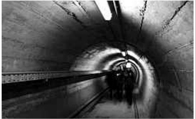
zvg. Eingangsstollen zur einst grössten Zivilschutzanlage der Schweiz
