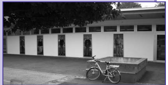
La façade est signée Berclaz de Sierre.
