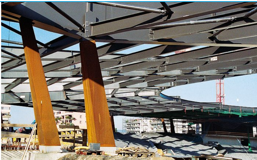
Das Stadion Letzigrund im Bau. 2007 wurde es mit dem Schweizer Stahlbaupreis Prix Acier ausgezeichnet.
