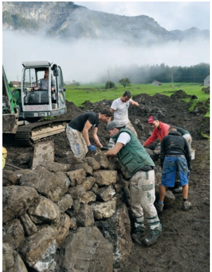
Mit grossem Einsatz und bei garstigem Wetter bauen die jungen Männer aus Zug im Muotathal eine Trockenmauer
